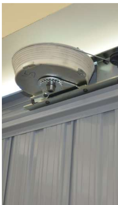
Sistema di bilanciamento a molla
