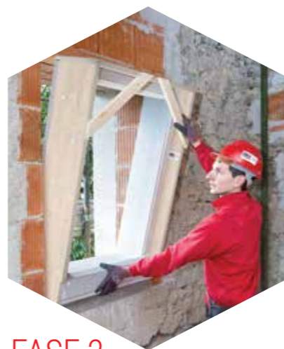
FASE 2 Alloggiamento nel vano.
