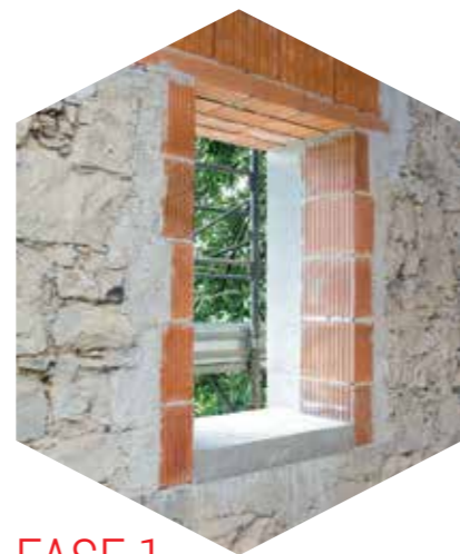
FASE 1 Predisposizione vano muro.
